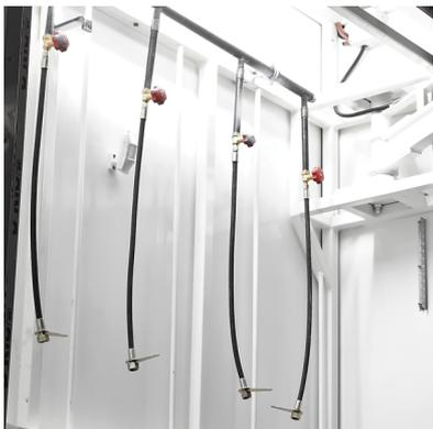
Там может быть номер для газ-танк, чтобы обеспечить необходимую энергию для оборудования, работающего с газом в Мобильной Полевой Кухне. Существует специальная система блокировки чтобы защитить от вибрации во время транспортировки. В нем есть газ сигнализация и газ-стоп система для обеспечения безопасности. Возможно производится с танком жидкого газа, который может быть заполнен от стандартных АЗС и можно обеспечить потребности в Газе благодаря испарения блок
