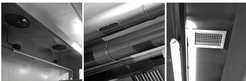
Отфильтрованная вытяжка и система аспиратор используется для удаления запаха и пара, который возникает во время приготовления пищи. Система кондиционирования воздуха используется на кухне, чтобы обеспечить комфортные условия эксплуатации. Системы кондиционирования воздуха могут быть канальный или сплит типа. В канальном кондиционер систем, воздух подается через каналами (двойная стенка изолированная) из нержавеющей стали.
